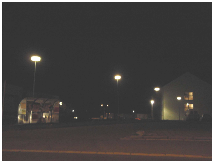
Svítidla nízko a se špatnou optikou
