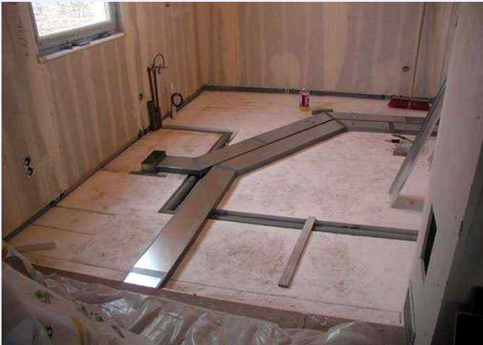
Paprskovité rozvody k jednotlivým vyústkám
